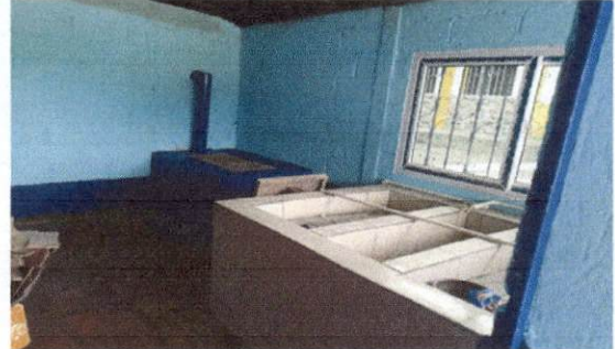
Foto 2: la pila terminada
